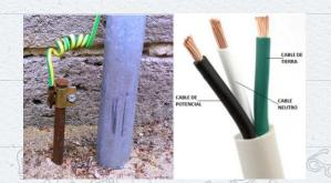
En nuestras conexiones eléctricas deberíamos encontrar una conexión compuesta de 3 cables con código de colores:
