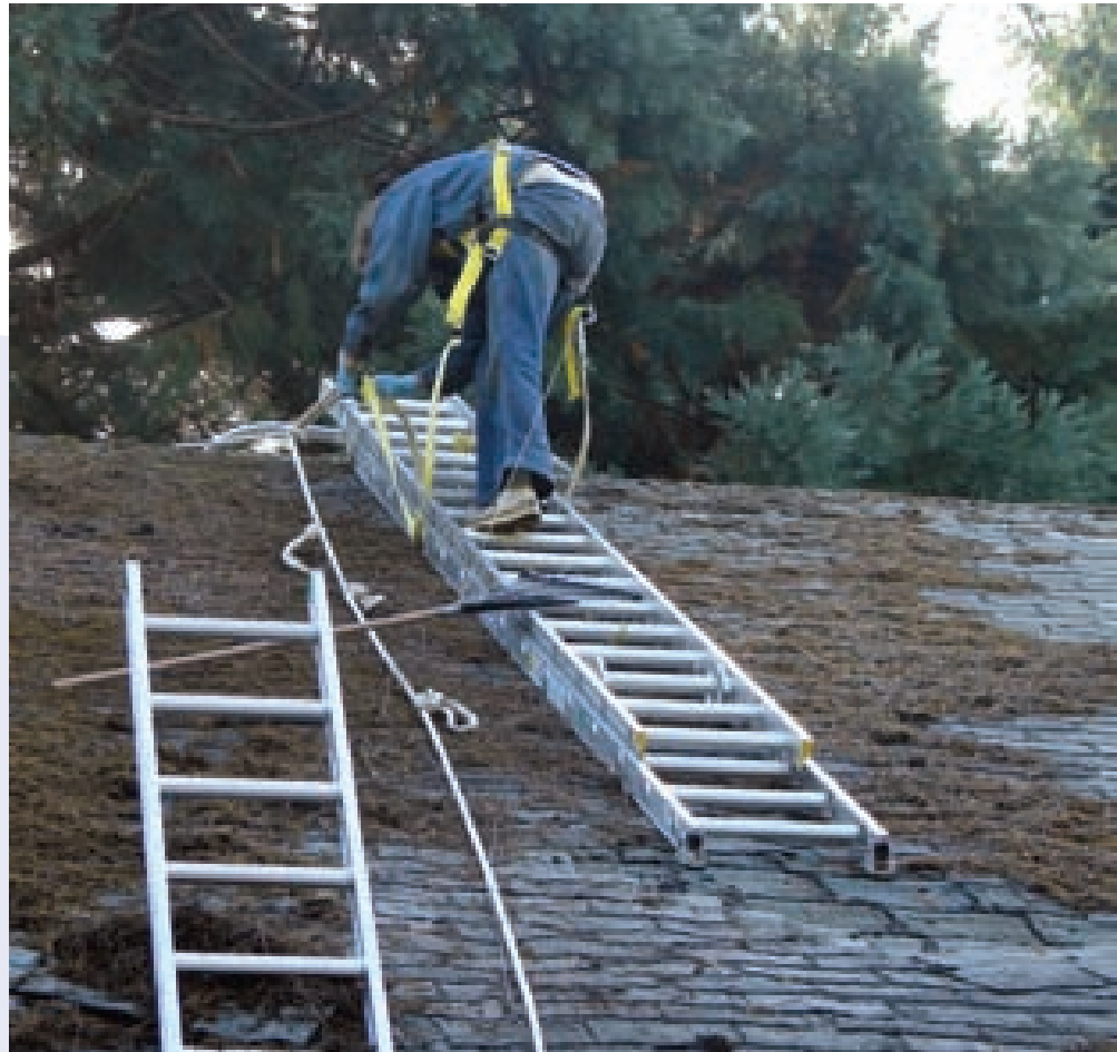
■ Distribución del peso reparando techos, foto Kevin Standlee, Oregon, USA.
