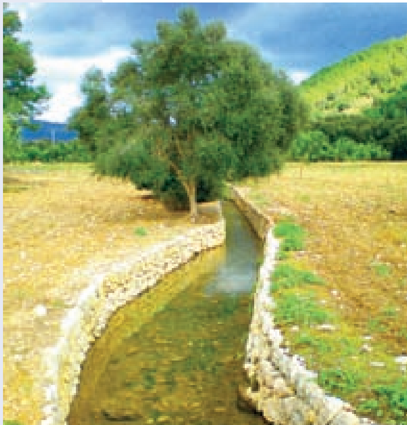
■ Usos de agua, canal agua para riego, Mallorca, España.
