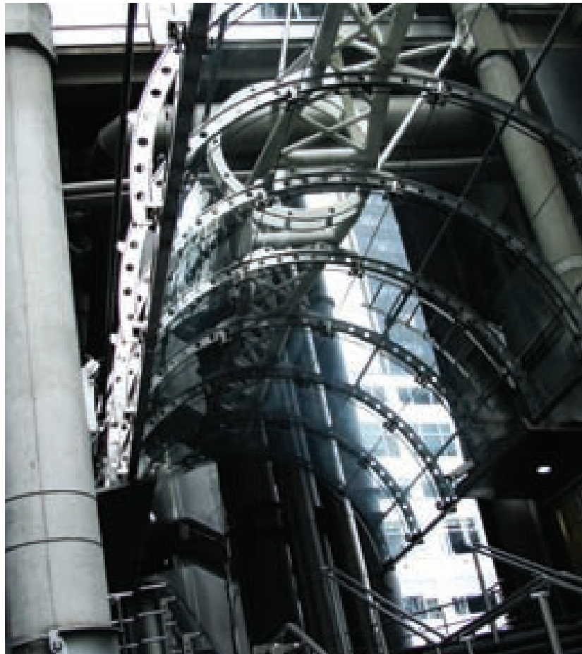
■ Estructura de acero, Constantin Jurcut, Londres, 2009.
