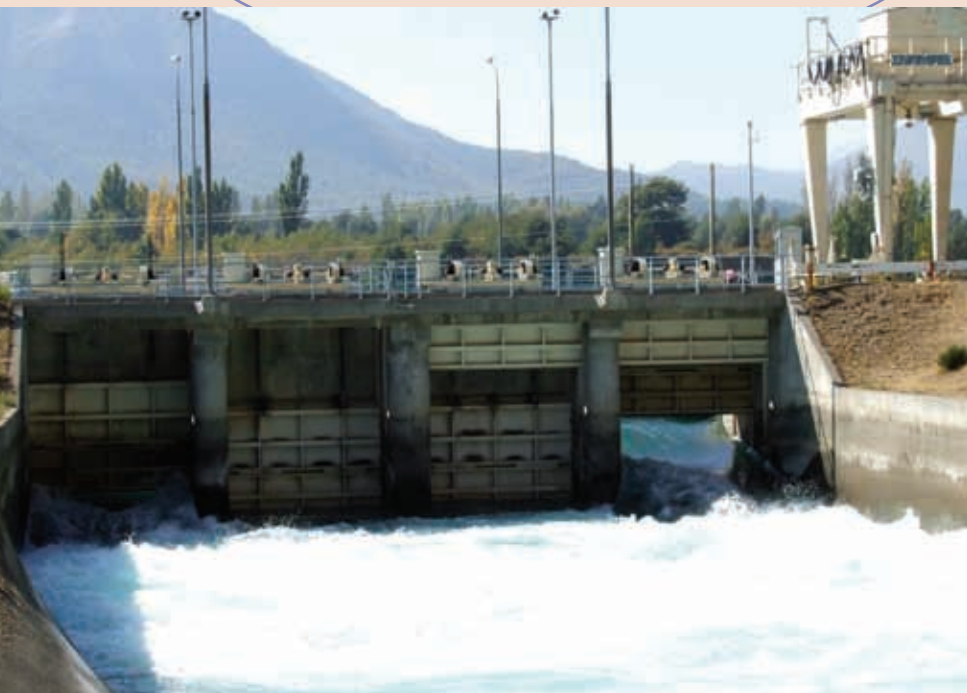
■ Central hidroeléctrica Maule 23. foto Javier Neira, 2008.
