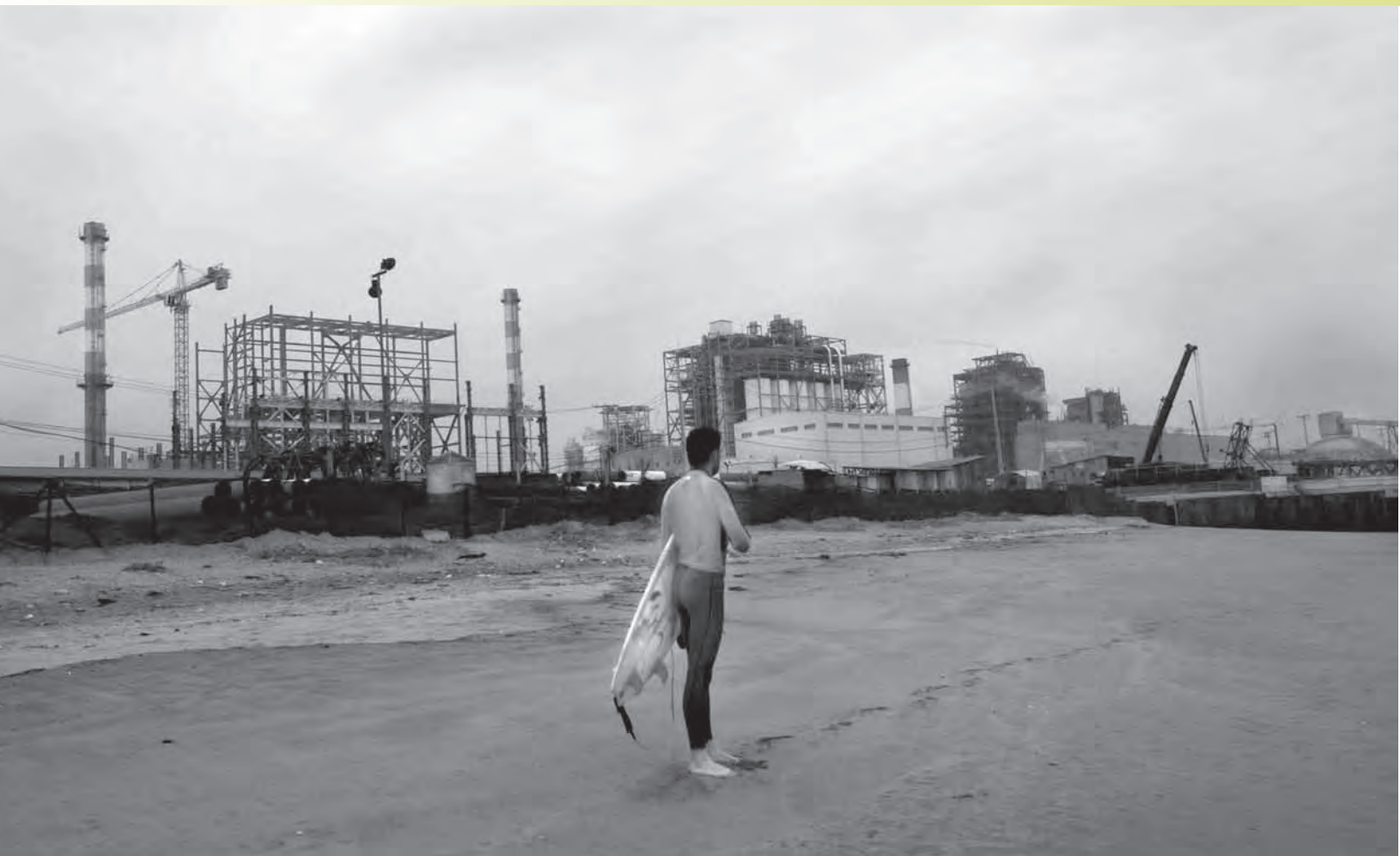
■ Contaminación del aire, que produce lluvia ácida, y de mar, termoeléctrica de Aes Gener, Ventanas, foto The Clinic, 2009.
